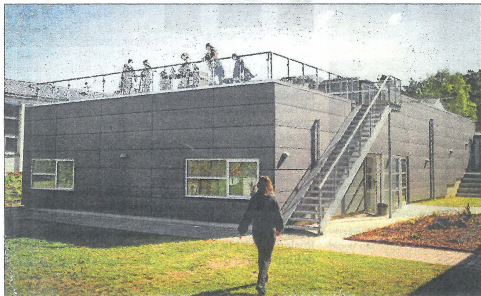
Seneste tilbygning på Svenstrup Efterskole er auditoriet med tilhørende tagterrace.
